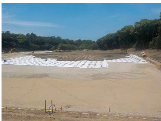
2. 盛土敷き均し
