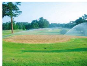
⑤目砂散布・転圧・散水
