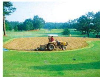
④苗差し込み・沈圧工
